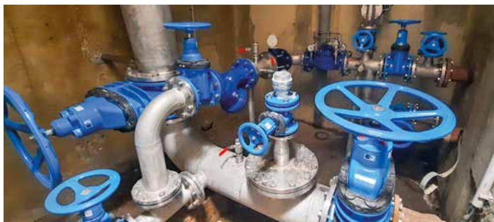
Die erneuerten Armaturen und Leitungen im Wasserverteilerschacht
