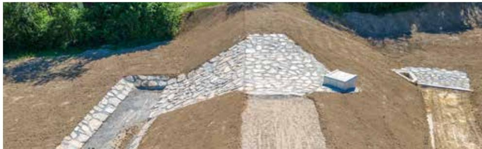
Die Arbeiten am Hochwasserschutz an der Vorgartenstraße in Höbersbrunn sind in der Endphase. Im hinteren Bereich werden noch Wege angelegt und teilweise mit Asphalt befestigt. Im Sommer/Herbst kann dann die Anlage umgehend in Betrieb gehen.
