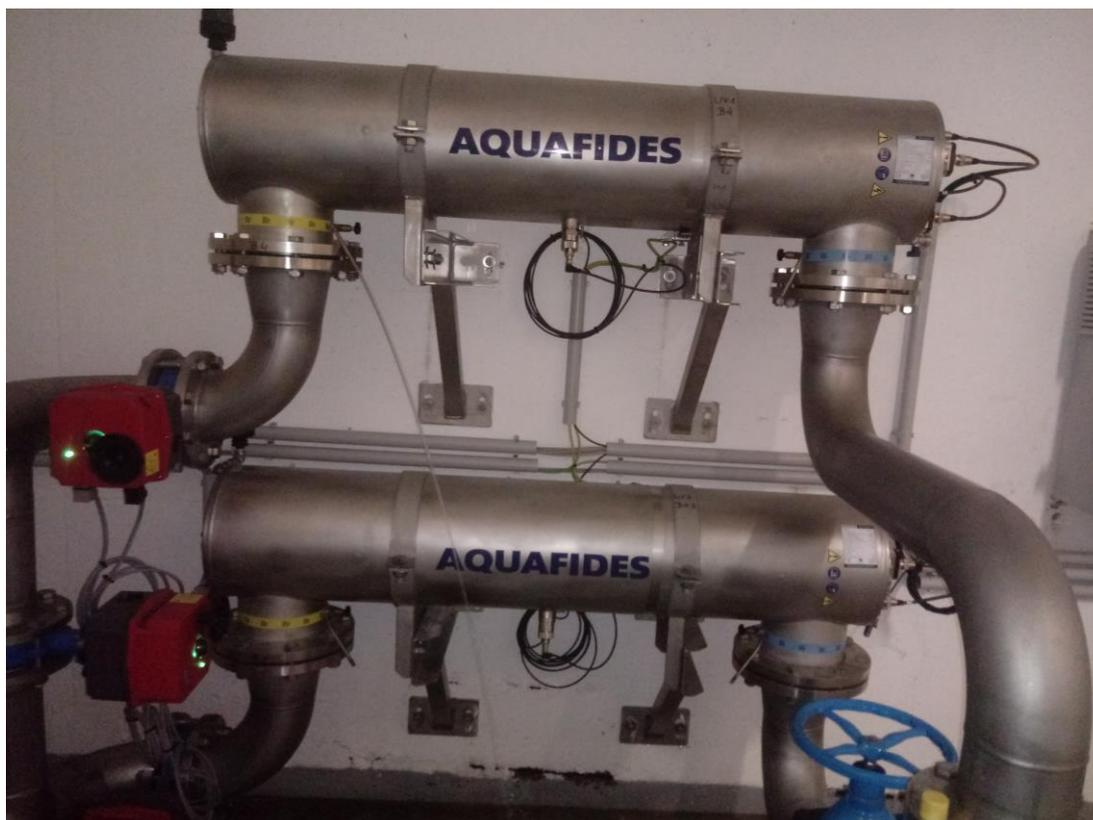
Abbildung 19: WVA Gaweinstal-Bad Pirawarth, Gerät Nr. 1 (oberes Gerät) und Nr. 2 (unteres Gerät) zur Desinfektion von Wasser mittels Ultraviolettstrahlung.
