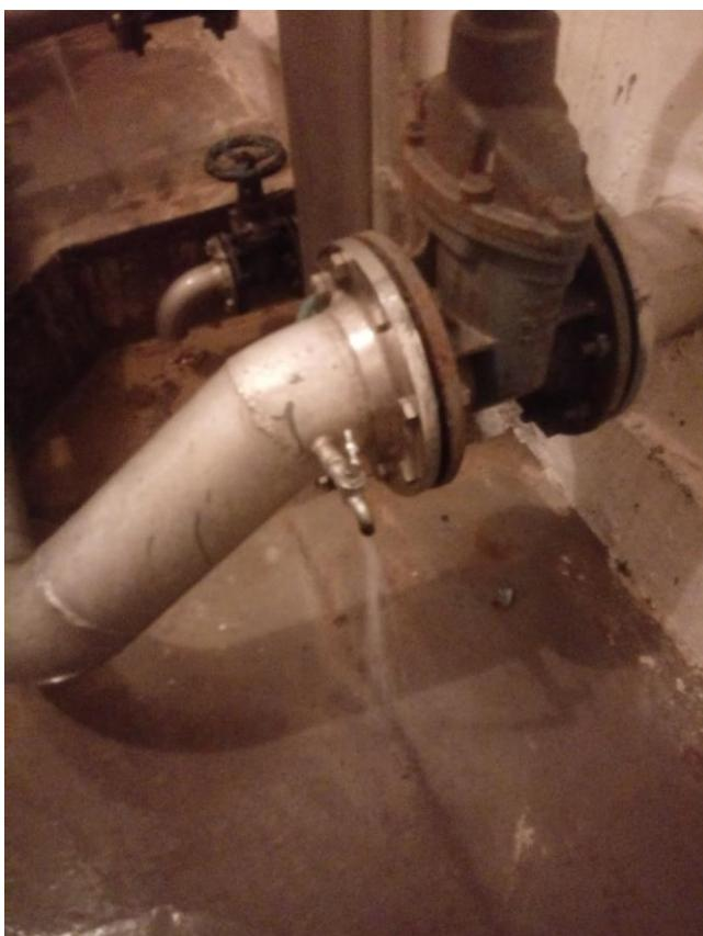
Abbildung 14: WVA Gaweinstal-Bad Pirawarth, Hochbehälter Süd, Probenahmestelle Behälterablauf.
