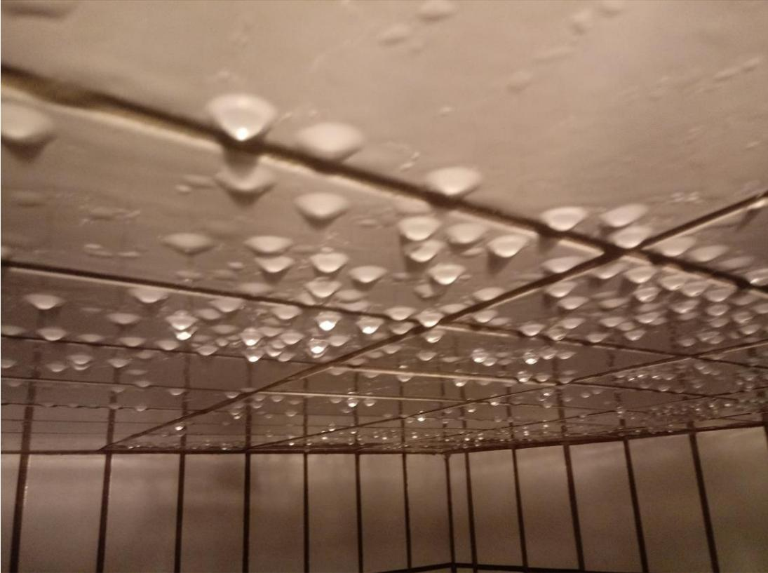
Abbildung 27: WVA Gaweinstal-Bad Pirawarth, Hochbehälter Kollnbrunn, Kondensat an der Behälterkammerdecke über der Wasserfläche.
